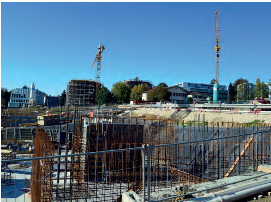
Vue de chantier Novembre 2014
